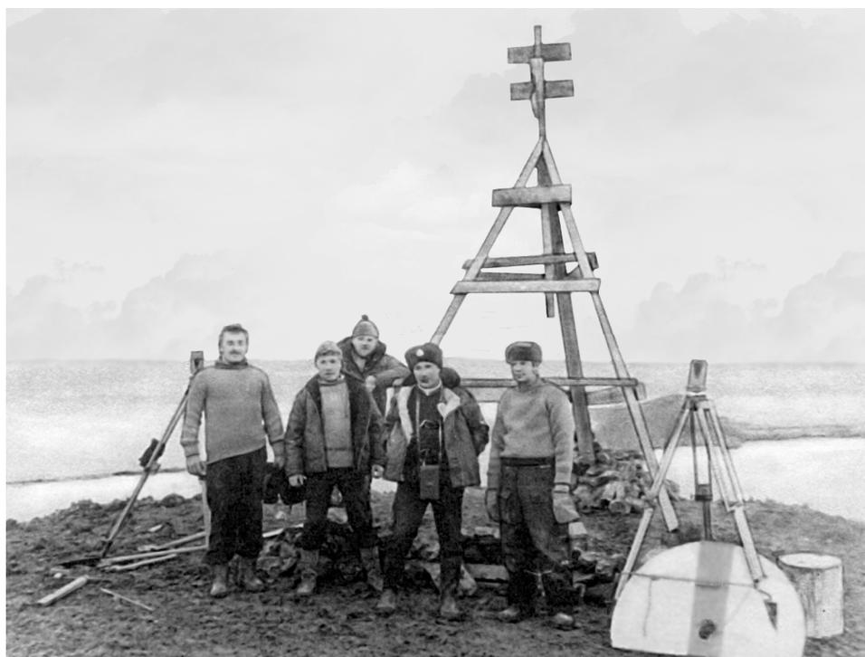
Рис. 4. Установка геодезического знака на станции «Беллингаузен»
